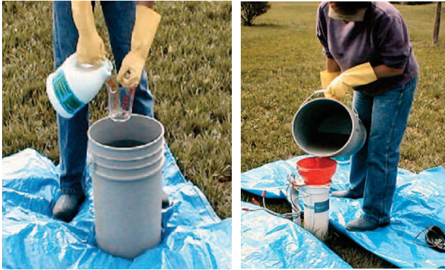
Figura 1. Determine la cantidad de blanqueador de cloro o hipoclorito de calcio necesario, mezcle y vierta la solución de cloro en el pozo. Fuente: Departamento de Salud de Minnesota. https://www.health.state.mn.us/communities/environment/water/docs/wells/waterquality/disinfection.pdf .
